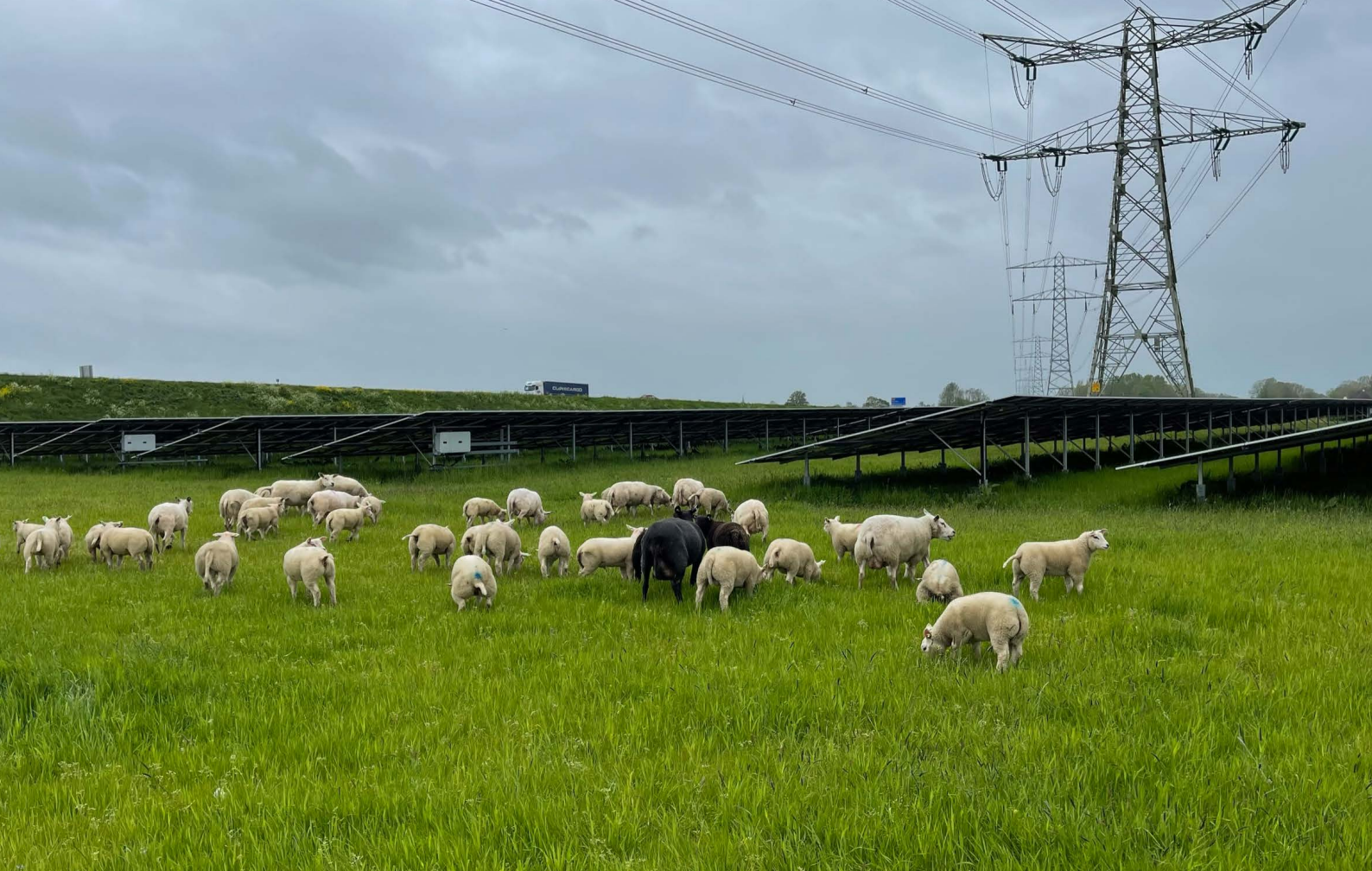
Solkraftverket «Drachtsterweg» bygget i 2020 av Energeia AS som også eier og driver solkraftverket i samdrift med innmarksbeite for sau.
