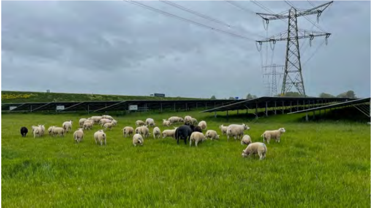
Bildet av «Drachtsterweg» solkraftverk i Leeuwarden kommune, Fryslân, Nederland. Solkraftverket er eid og bygget i 2020 av Energieia AS og drives i samdrift med innmarksbeite.
