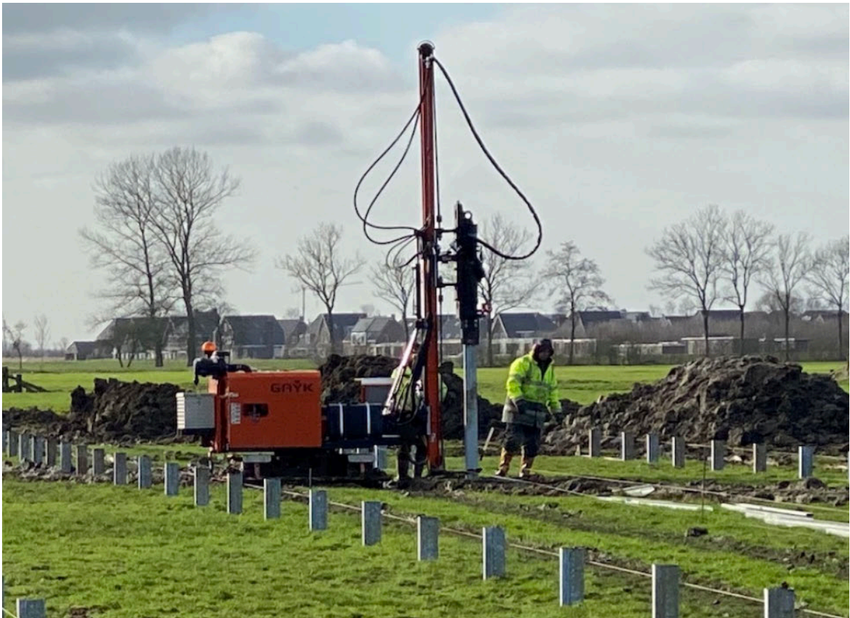
Figur 11 Eksempel på pælemaskin for fundamenter fra konstruksjonen av Energeias solkraftverk i Nederland.
