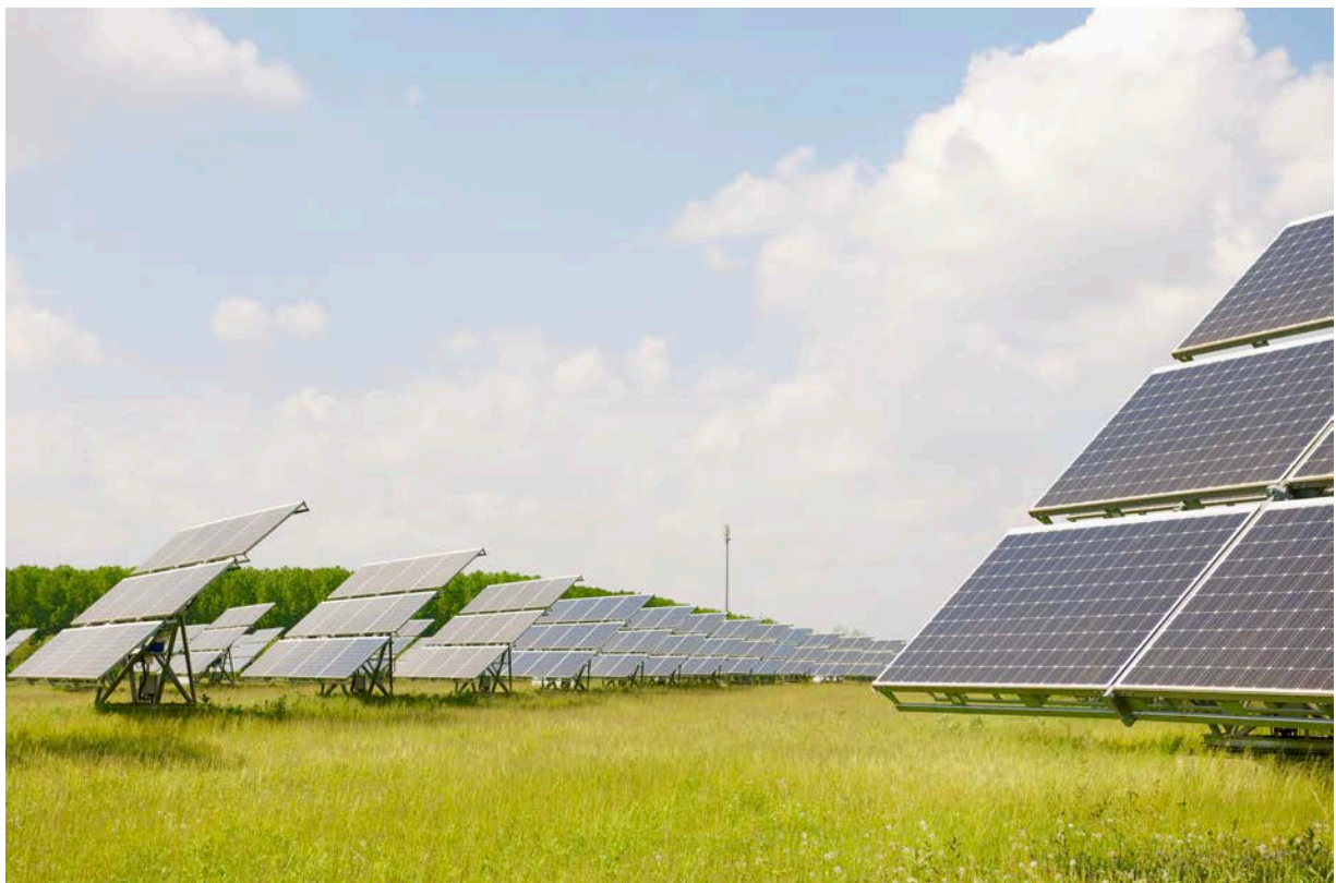
Figur 5 Bilde fra Energeia-gruppens solkraftverk i Friuli-Venezia Giulia, i Italia, med to-akse følgestructur.
