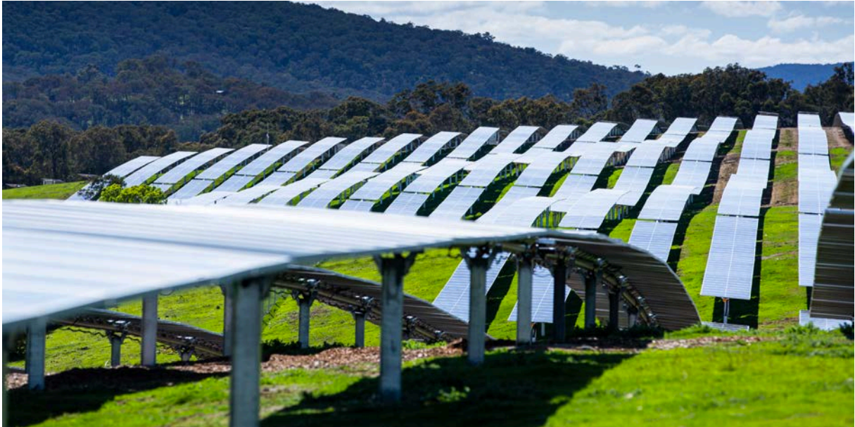
Figur 9 Illustrasjonsfoto én-akse systemet NX-Horizon -XTR levert av selskapet Nexttracker. Foto fra Nexttracker.
